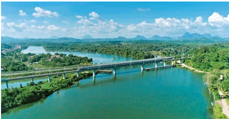
进出口银行支持的中老铁路项目
