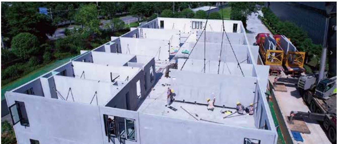
远大住工 PC 绿色工业化建筑安装现场
