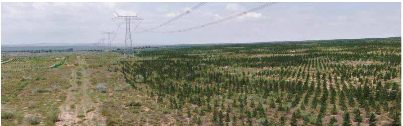
线路运维前后的周边景观变化
