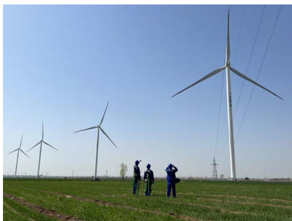
中国节能所属风电河南公司中节能温县100兆瓦风电项目
